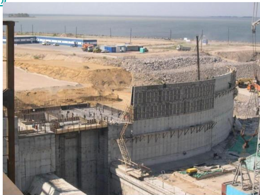
Южная струенаправляющая стена и южный пилон на отм. 0,000.
