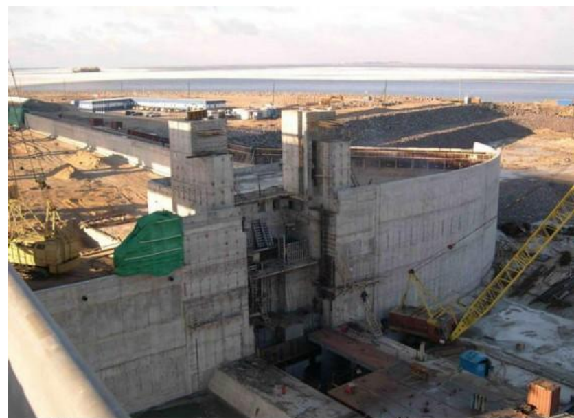
Южная струенаправляющая стена на отм. +8,100 и южный пилон на отм. +21,000.
