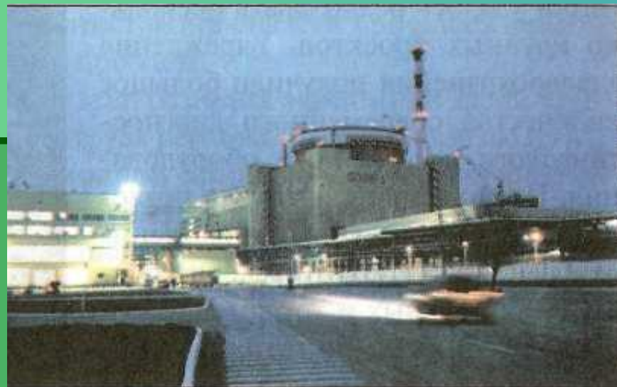
Ростовская Атомная электростанция
