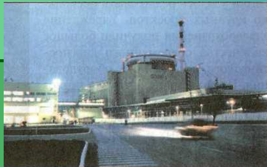
Ростовская Атомная электростанция
