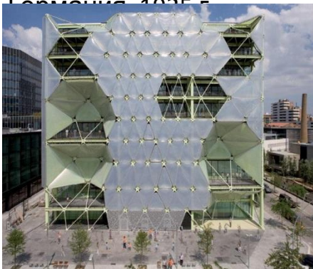
Офис Media-Tic, Барселона, 2011 г.
