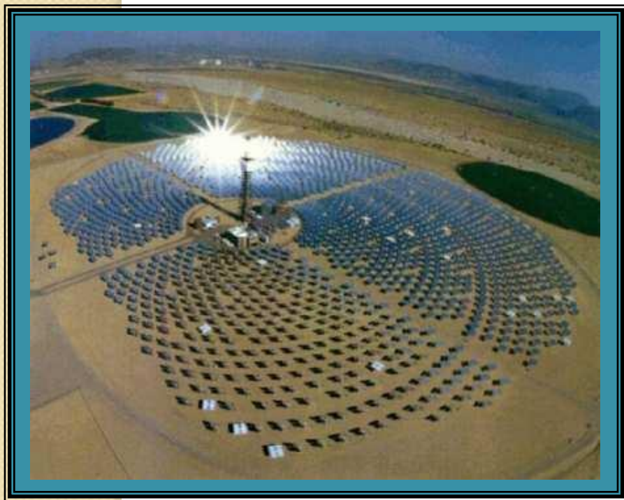
Солнечная электростанция (СЭС)
