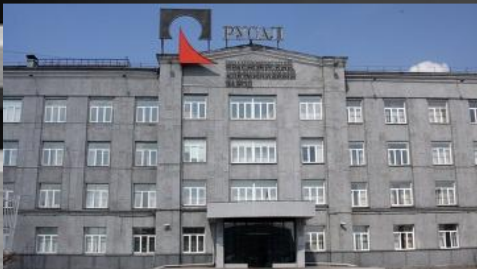
Красноярский алюминиевый завод
