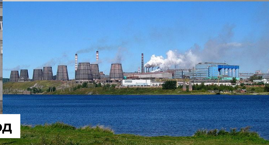
Богословский алюминиевый завод
