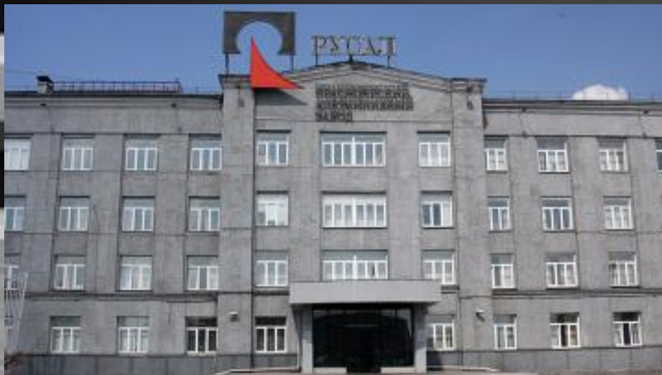
Красноярский алюминиевый завод
