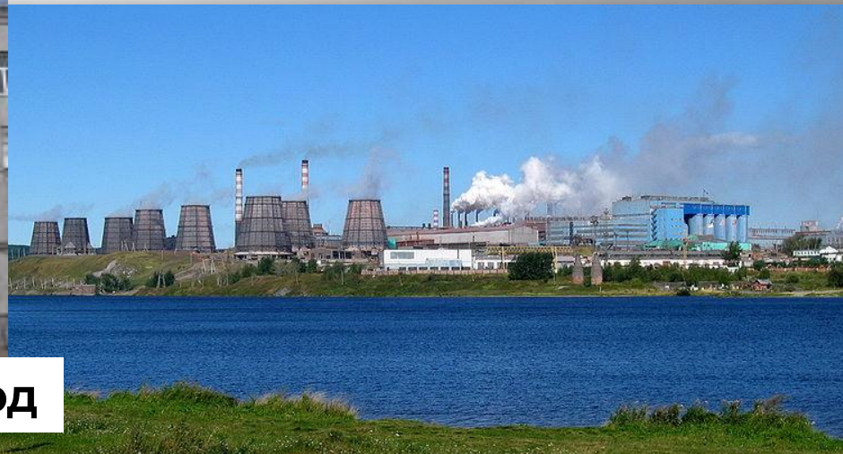
Богословский алюминиевый завод
