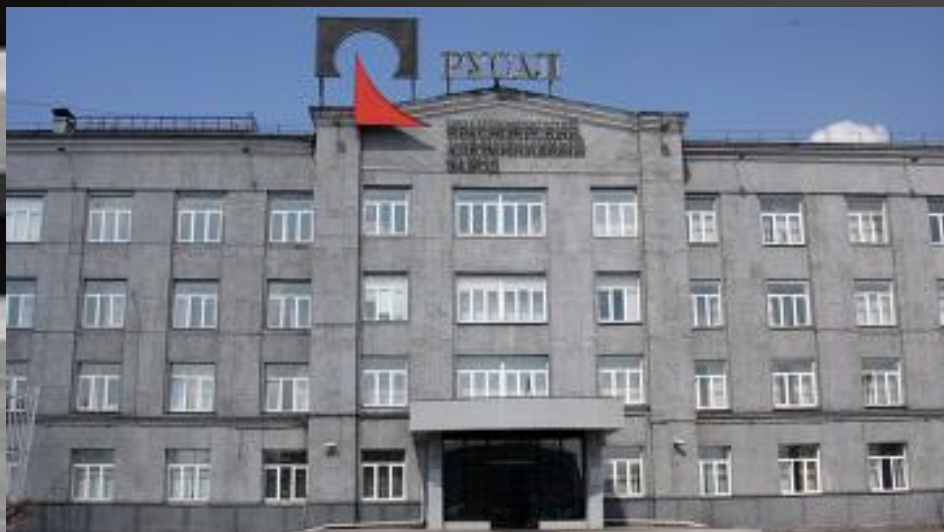
Красноярский алюминиевый завод
