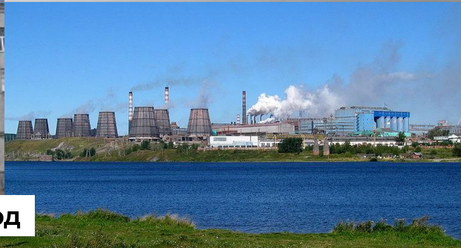
Богословский алюминиевый завод
