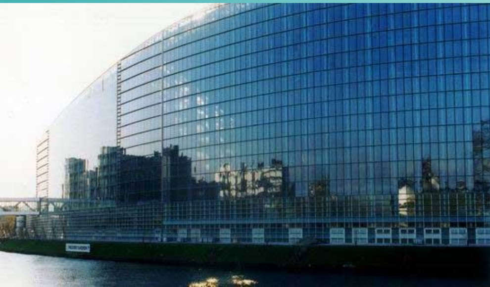
Здание ЕЭС в Брюсселе
