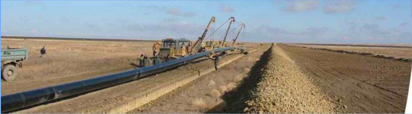
Укладання нафтопроводу.
