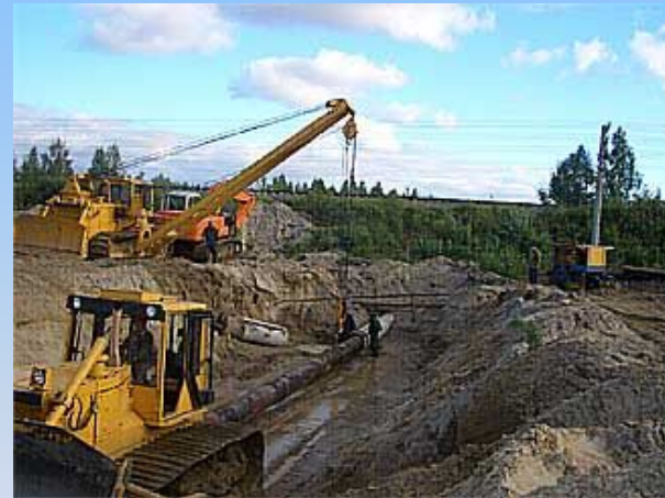
Укладання нафтопроводу.
