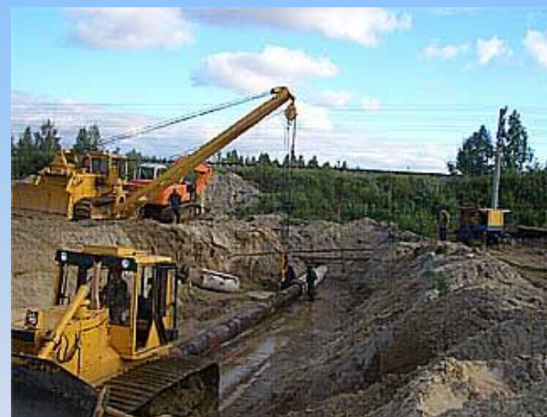
Укладання нафтопроводу.
