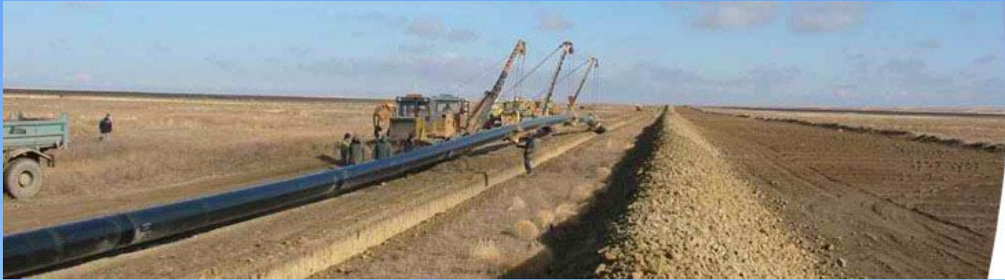
Укладання нафтопроводу.
