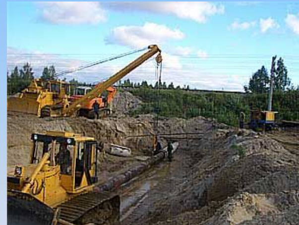
Укладання нафтопроводу.
