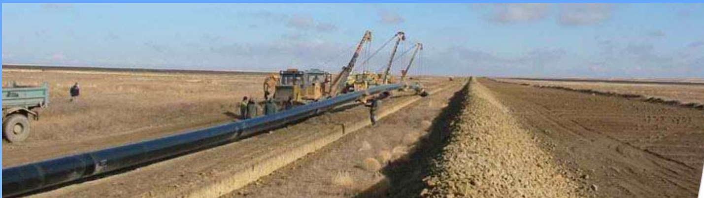
Укладання нафтопроводу.
