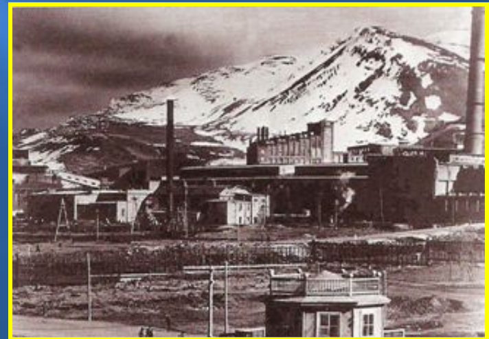
Малый Металлургический завод
