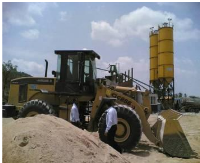
Строительство обьездной дороги в Ченнаи
