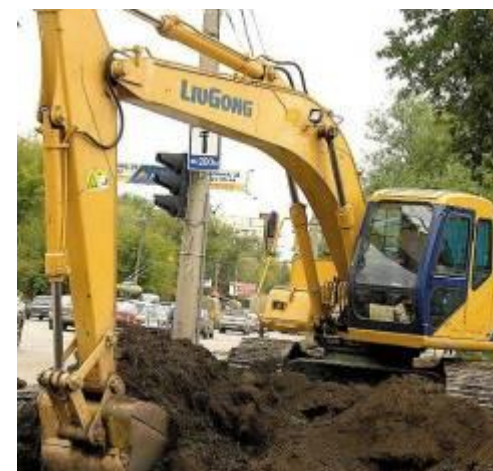
Экскаватор CLG220LC на ремонте дороги в Челябинске.
