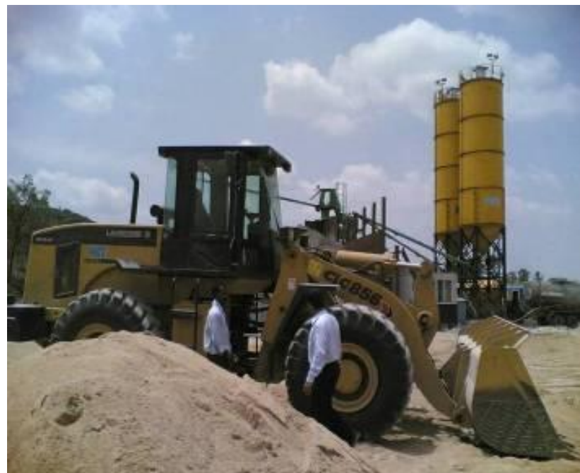
Строительство объездной дороги в Ченнаи
