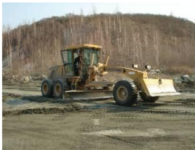
Автогрейдер CLG418 на ремонте дороги.
