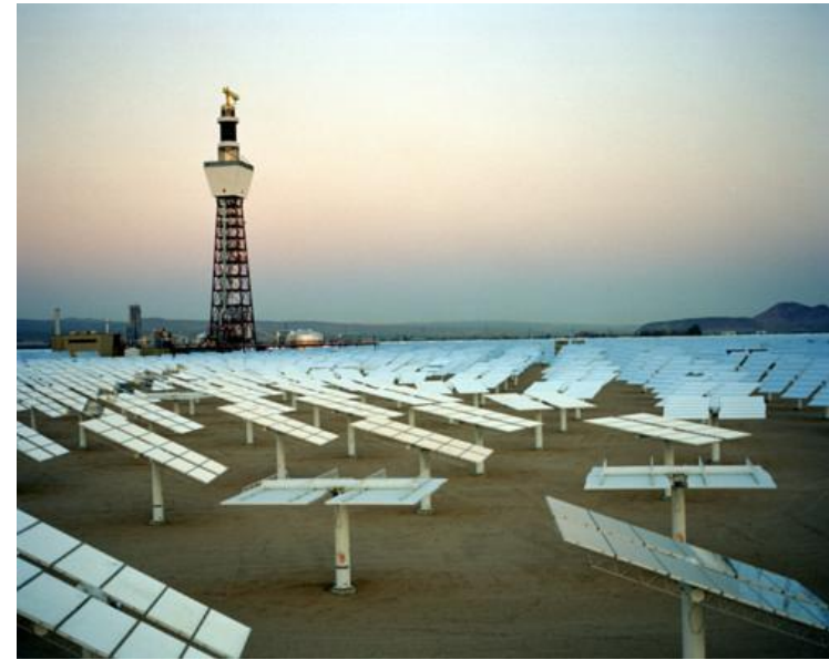
Гелиотермальная электростанция в Калифорнии
