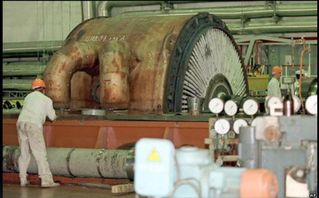
Демонтаж турбины Чернобыльской АЭС
