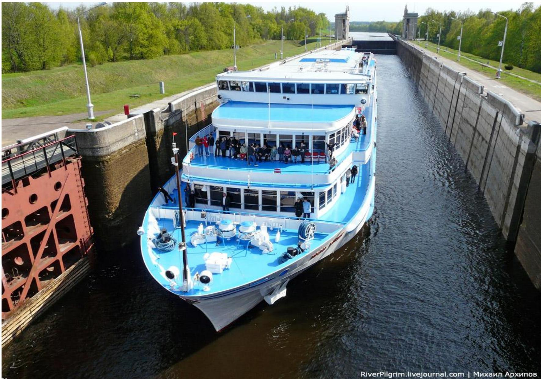
Шлюзы - камеры, расположенные между водоемами с различными **уровнями** воды.
