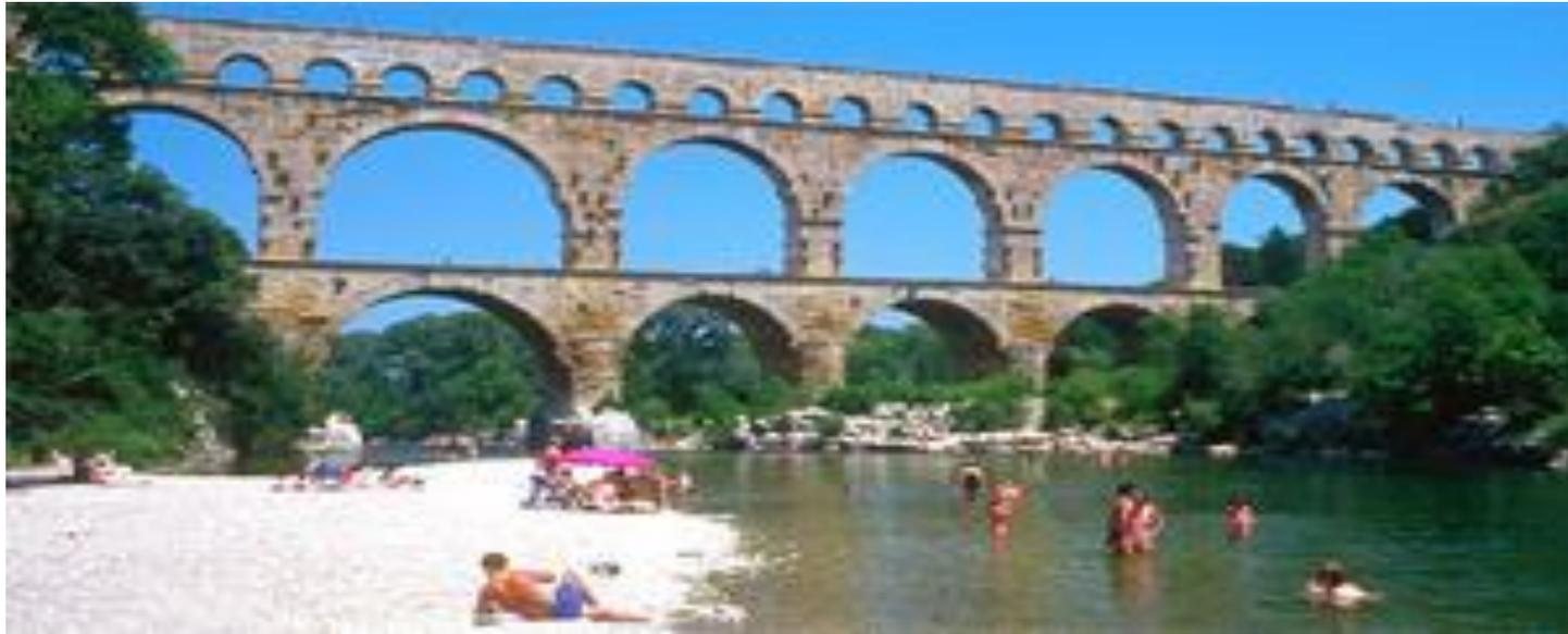
**Акведук - это водяной желоб, поддерживаемый мостами. Вода бежит по акведуку над впадинами и холмами под действием собственного веса - от горных потоков к городам, расположенным в долине. Акведуки использовались в древние времена в качестве наземных прообразов современных систем водоснабжения. В те времена люди еще не знали закона сообщающихся сосудов, но активно использовали его в акведуках.**
