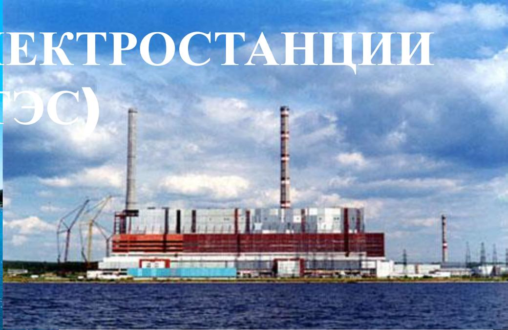
тепловые электростанции тепловые электростанции — электростанция тепловые электростанции — электростанция, вырабатывающая электрическую энергию за счет преобразования химической энергии топлива тепловые электростанции — электростанция, вырабатывающая электрическую энергию за счет преобразования химической энергии топлива в механическую энергию вращения вала тепловые электростанции — электростанция
