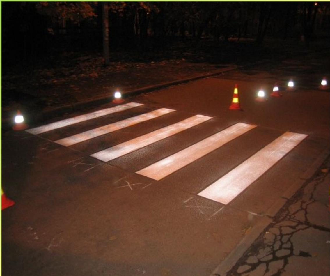
Явление люминесценции используется при изготовлении светящихся красок и световых составов. Люминесцентные полимерные композиции используют для дорожной разметки.
