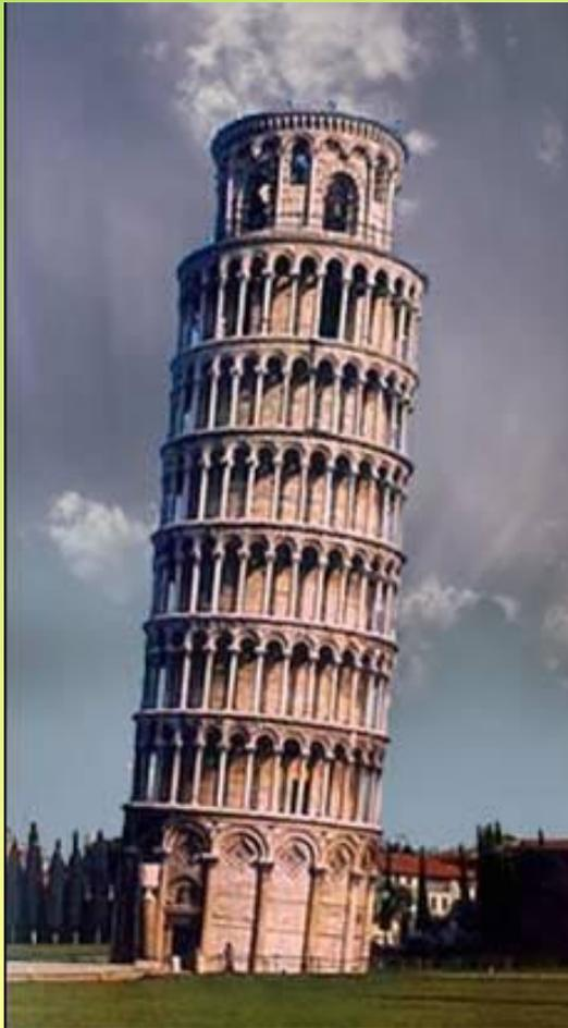
Высота башни 54,5 м. Вершина башни отклонена от вертикали на 4,5 м. Равновесие нарушится и башня упадет, когда отклонение её вершины от вертикали достигнет 14 м.
