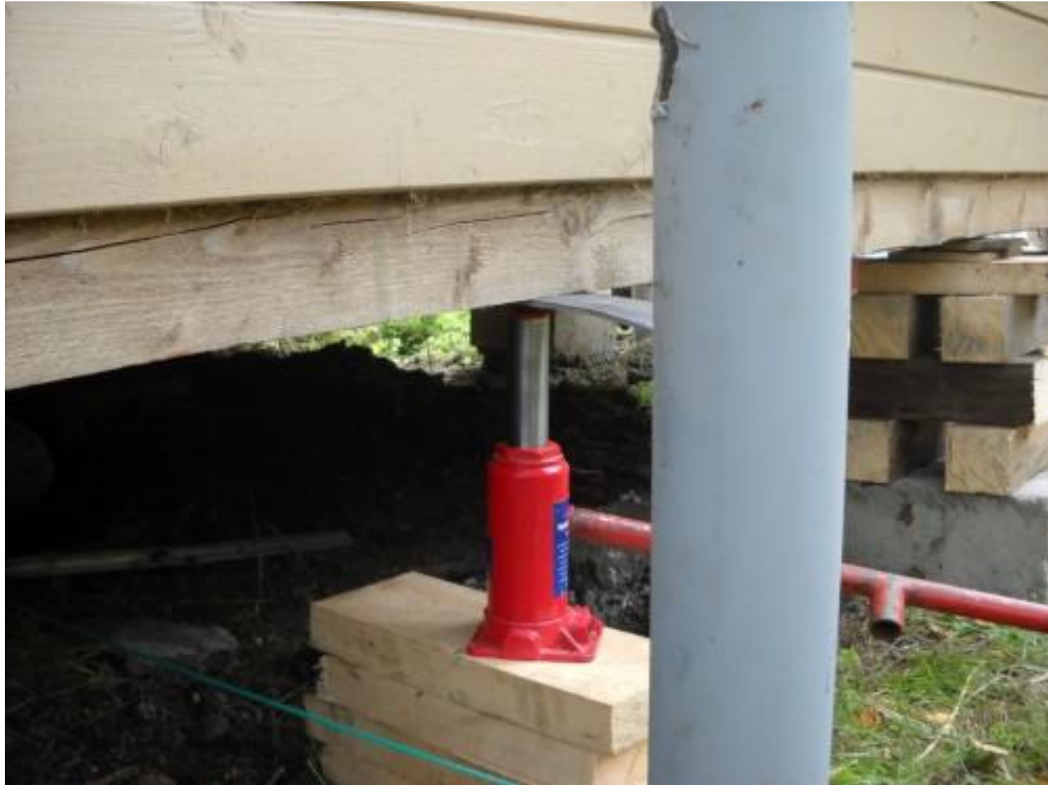
Поднятый домкратом сруб деревянного дома
