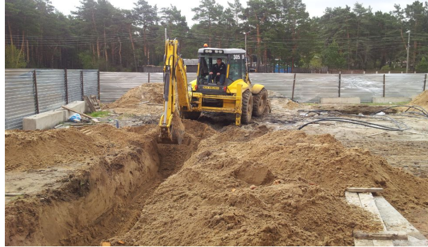
Траншея глубиной 2м. для подведения трубок к школе.
