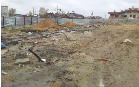
Погружение отопительных трубок в скважины.
