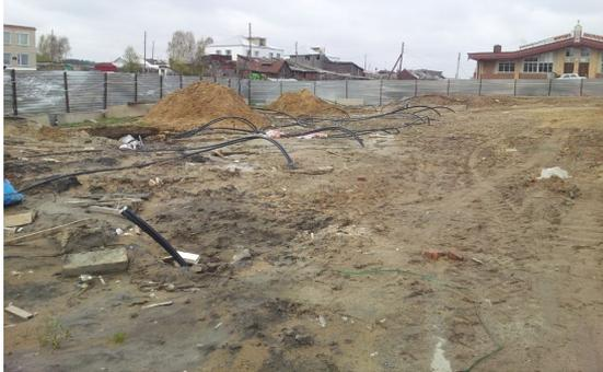
Погружение отопительных трубок в скважины.
