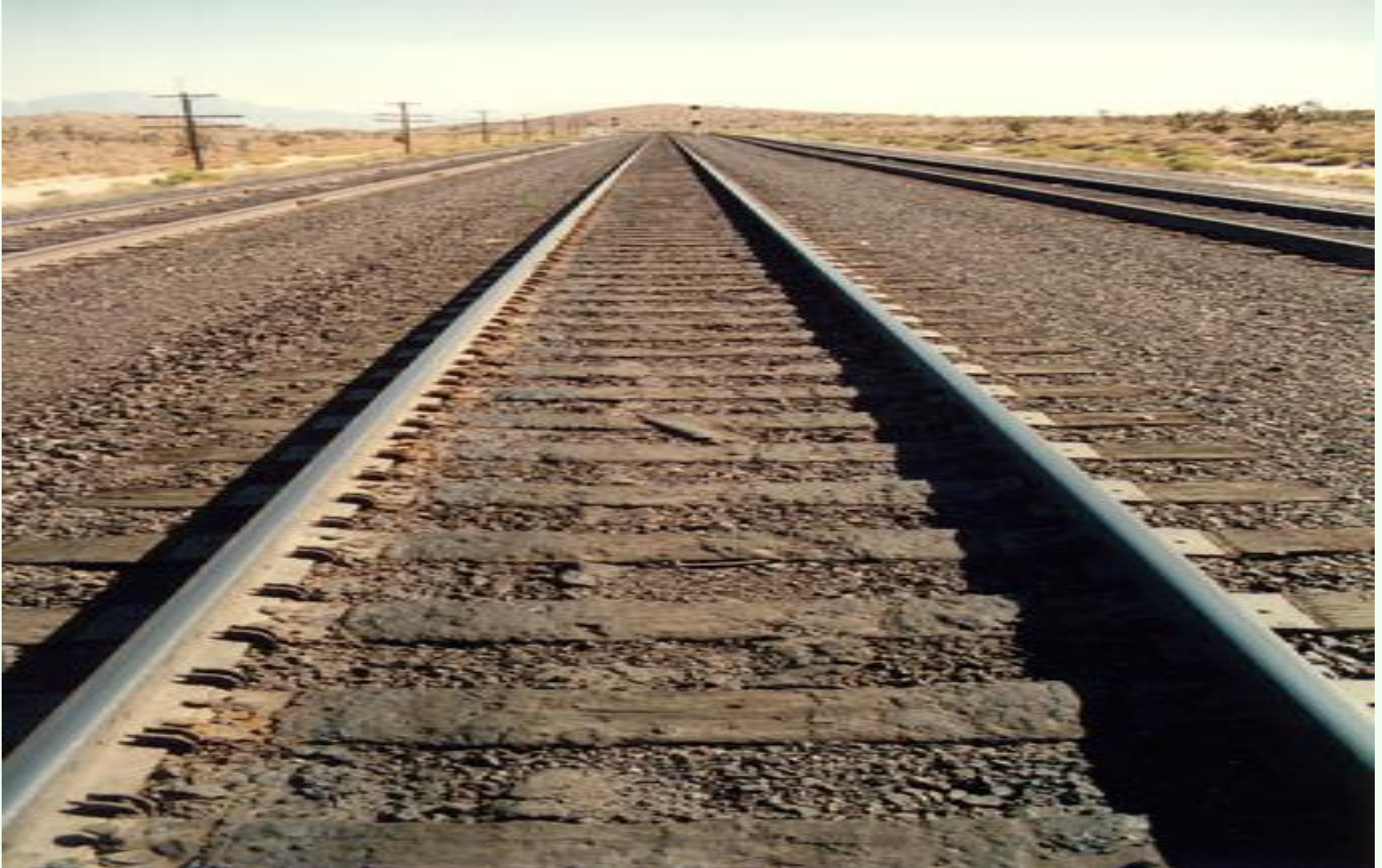
Шпалы железной дороги
