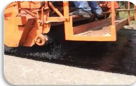
5. Щебеночная защита поверхностного слоя износа дорожного полотна
