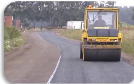
6. Уплотнение поверхностного слоя
