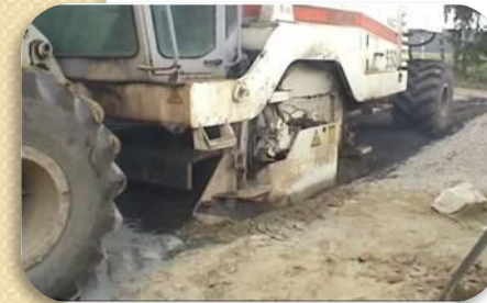
3. Холодный ресайклинг дорожного полотна
