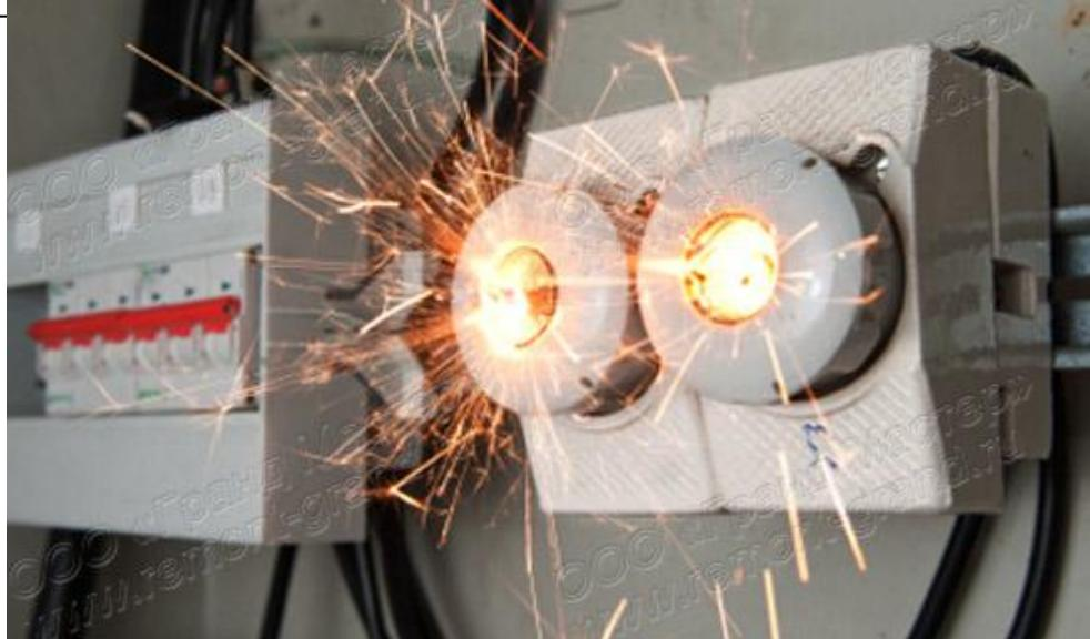
Сопротивление цепи при коротком замыкании незначительно, поэтому, следуя закону Ома, в цепи возникает большая сила тока, провода при этом сильно нагреваются и становятся причиной пожара. Чтобы избежать этого, в сеть включают предохранители.
