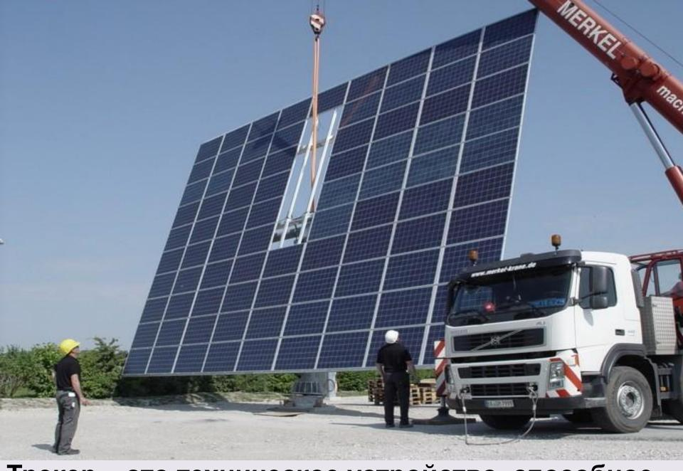
**Трекер** – это техническое устройство, способное поворачиваться вслед за Солнцем.
