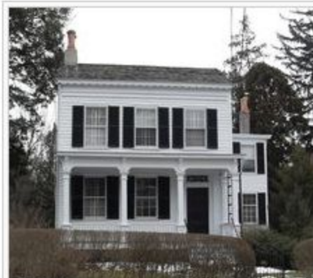
Дом Эйнштейна в Принстоне
