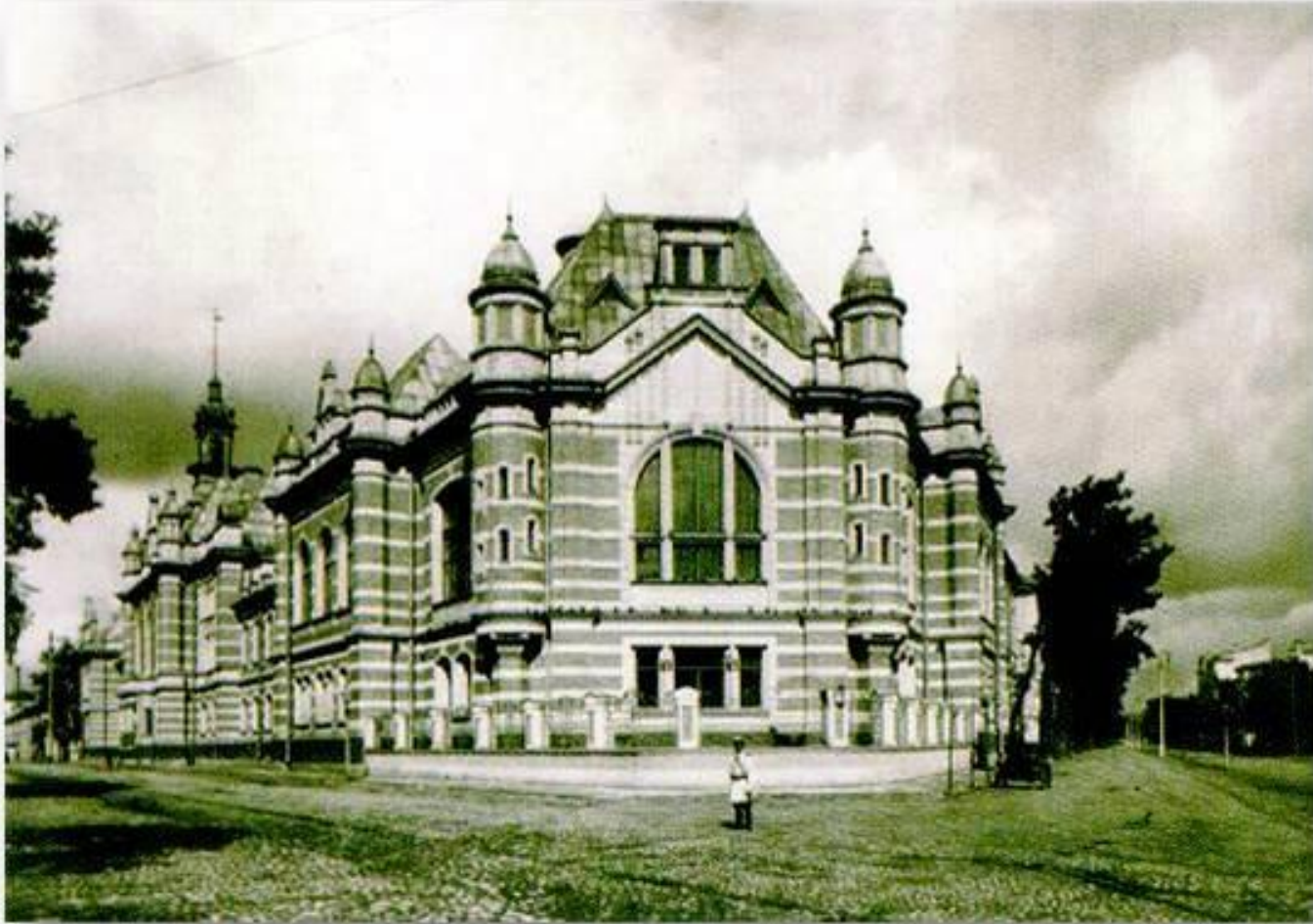
Здание Электротехнического университета в начале века.
