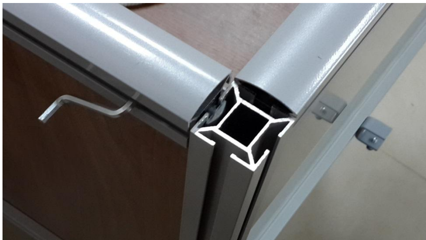
Соединение стойки с прогоном:
