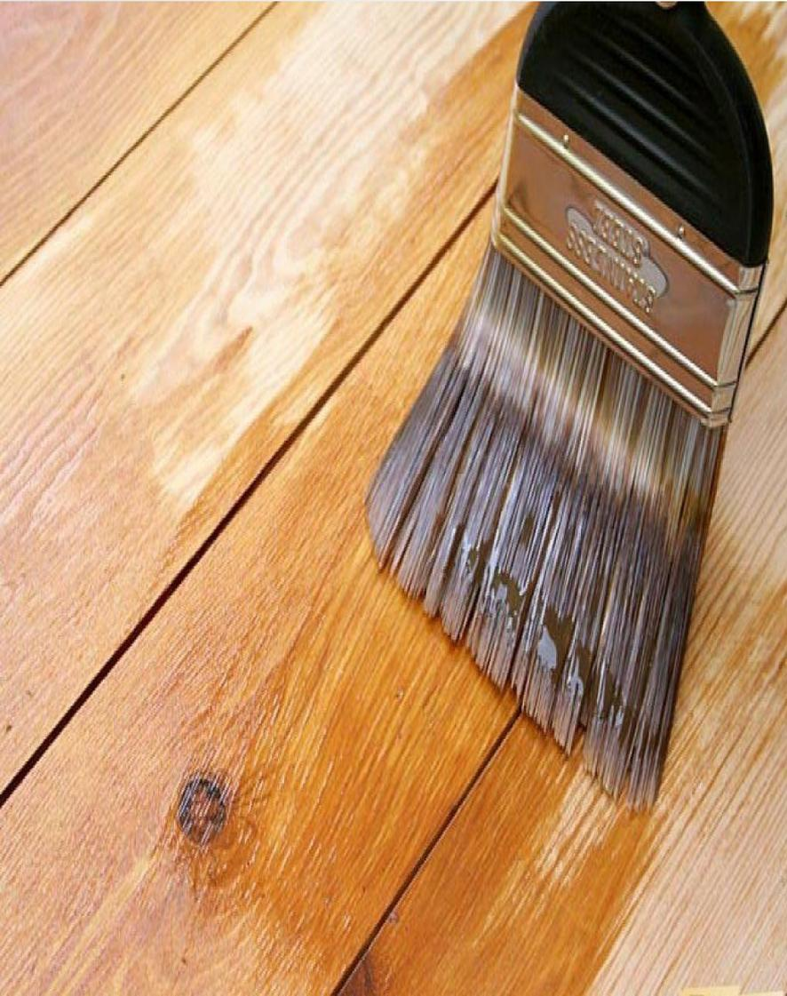
В конце когда конструкция полностью обработана. Наносят последний защитный слой – лак.
