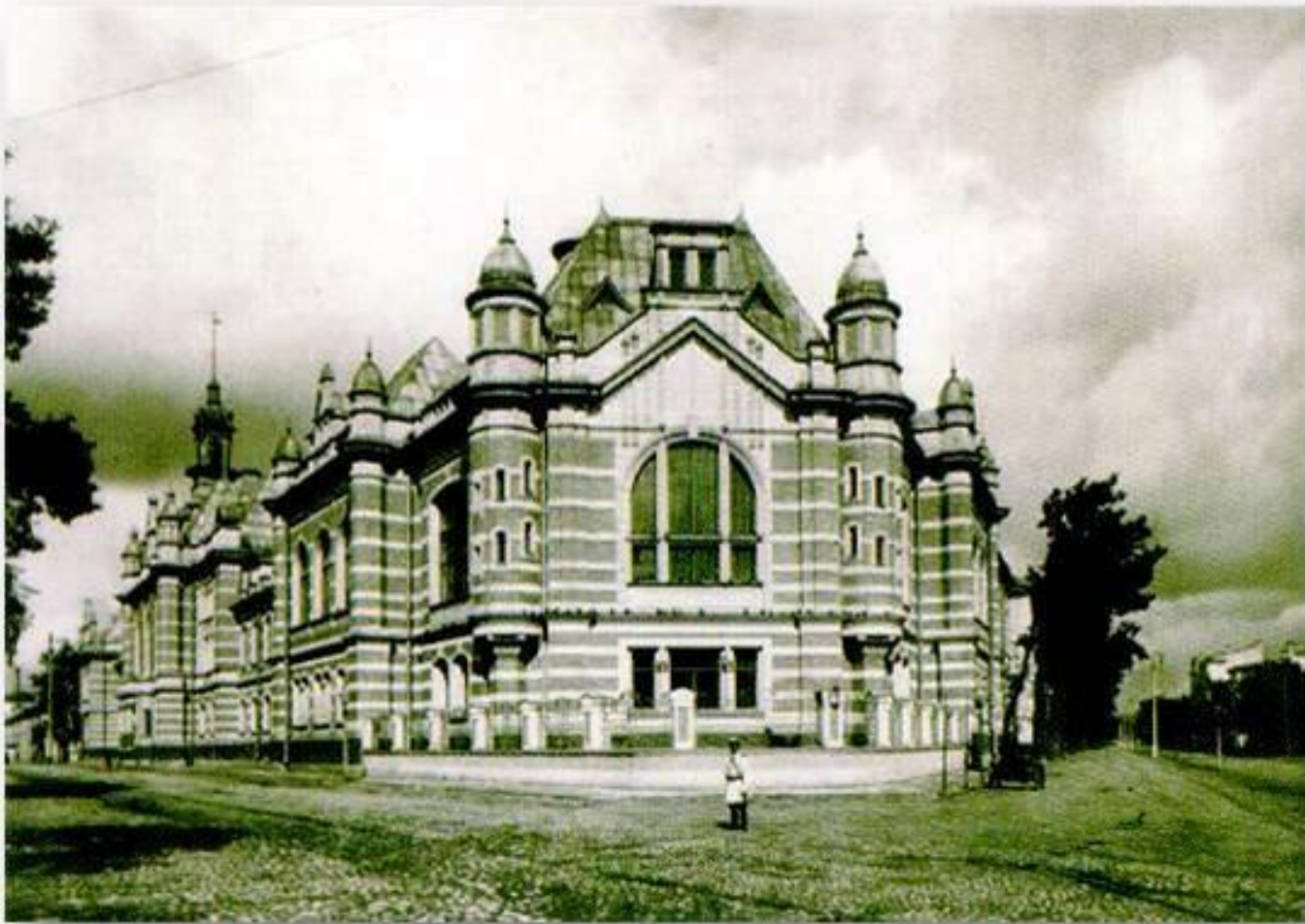
Здание Электротехнического университета в начале века.
