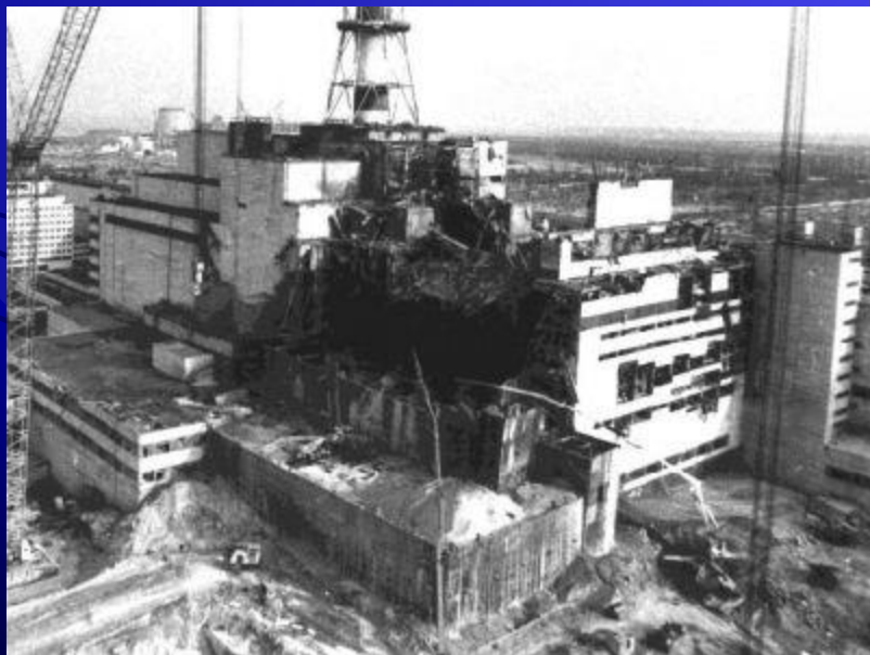
Разрушенный 4-й энергоблок
