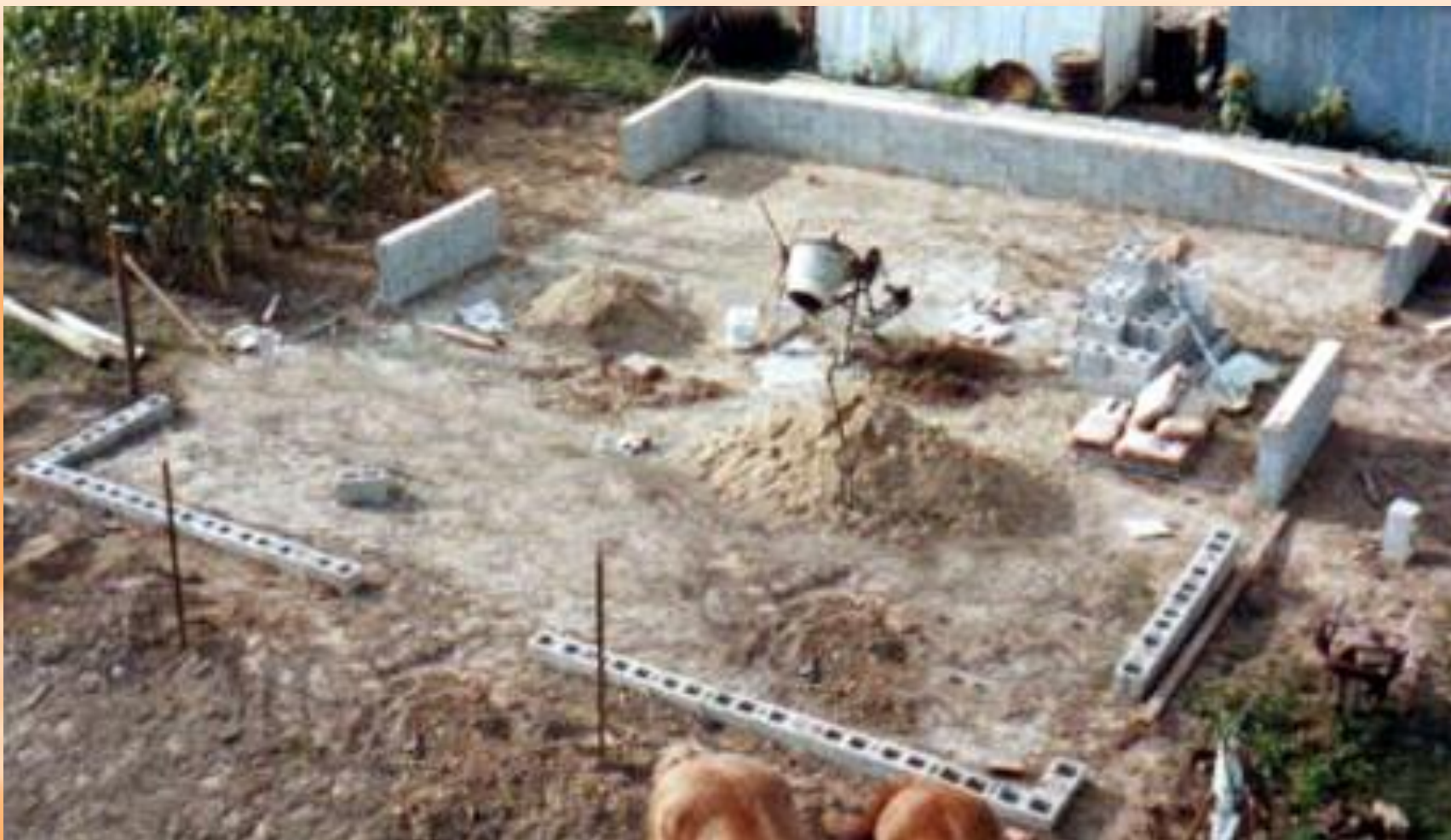
Закладка фундамента здания
