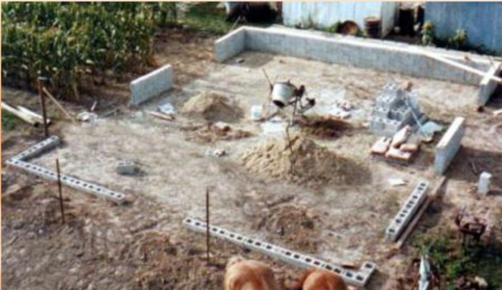
Закладка фундамента здания
