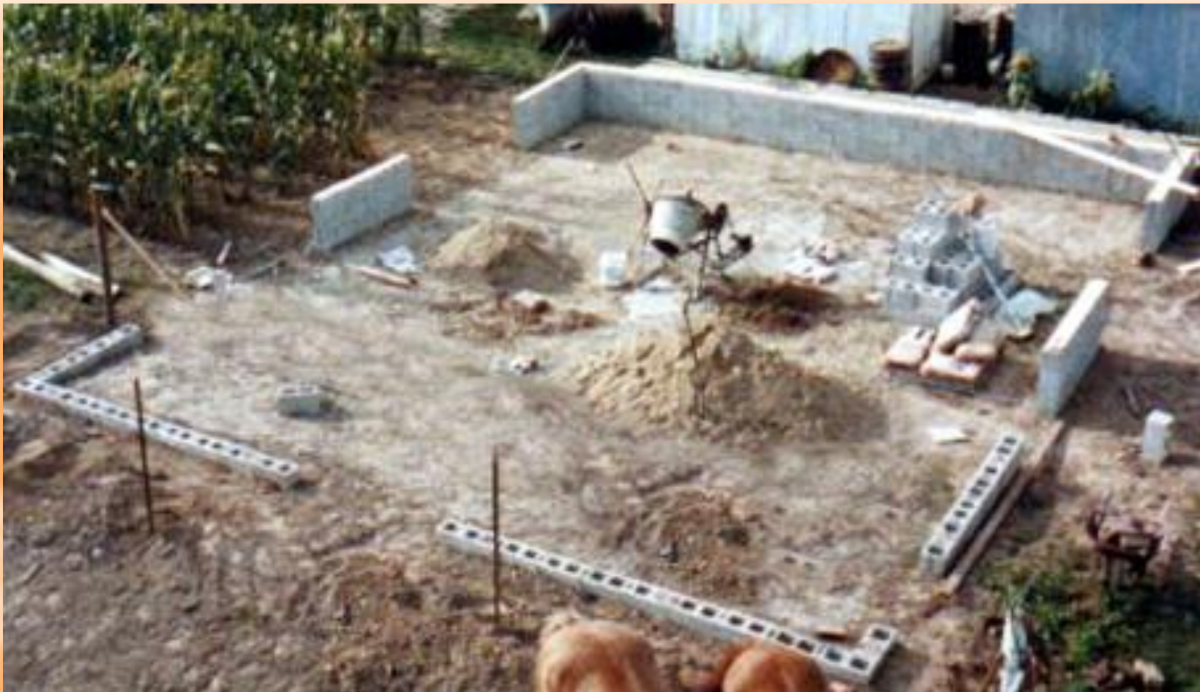
Закладка фундамента здания
