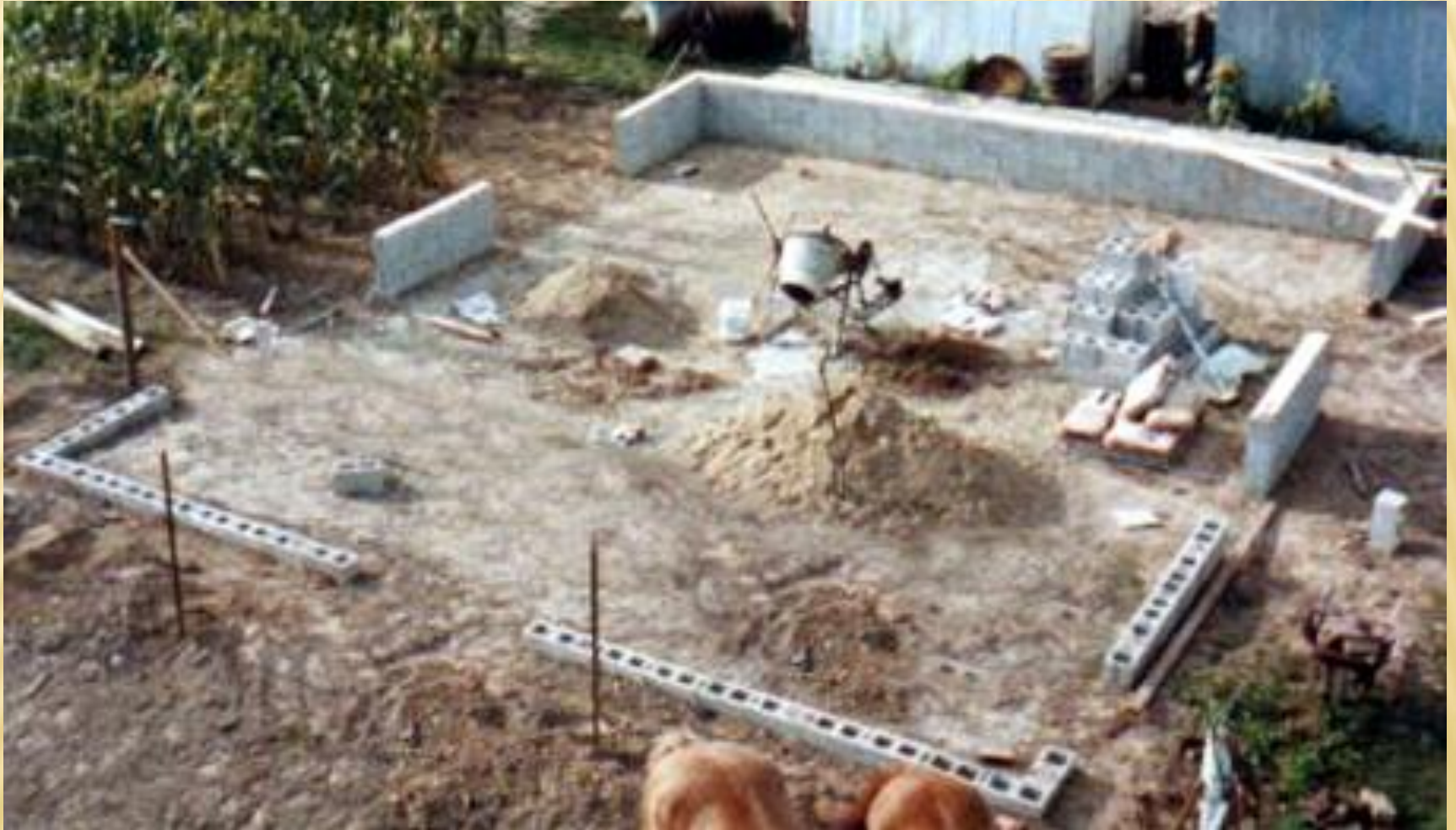
Закладка фундамента здания
