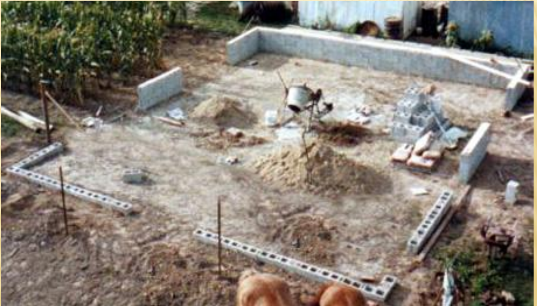
Закладка фундамента здания
