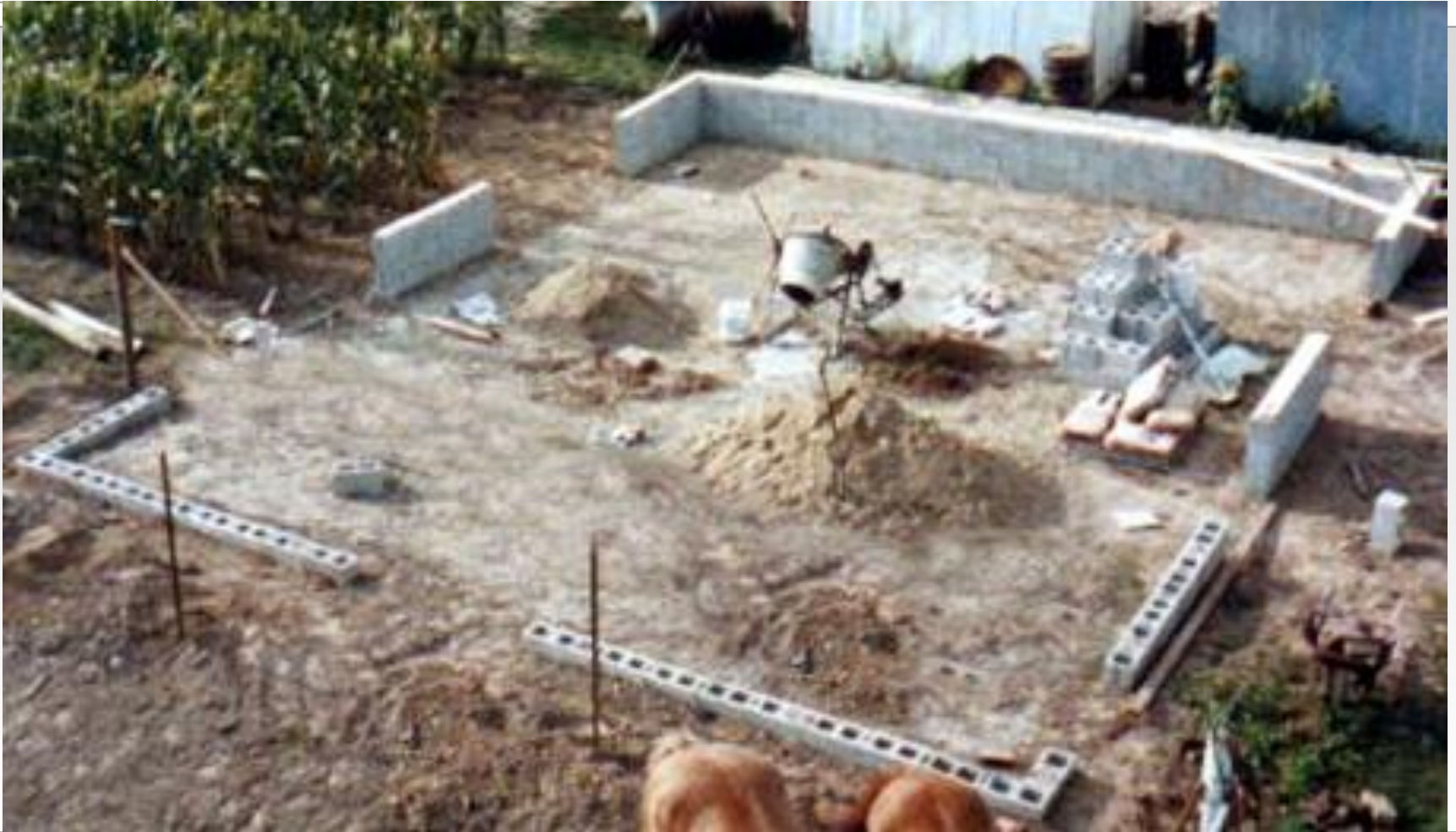
Закладка фундамента здания
