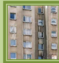
Использована простая фасадная краска.
