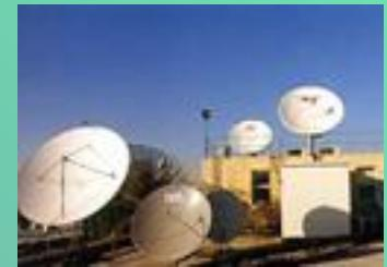
Радиолокационные и радарные установки имеют обычно антенны рефлекторного типа («тарелки») и излучают узконаправленный радиолуч.
