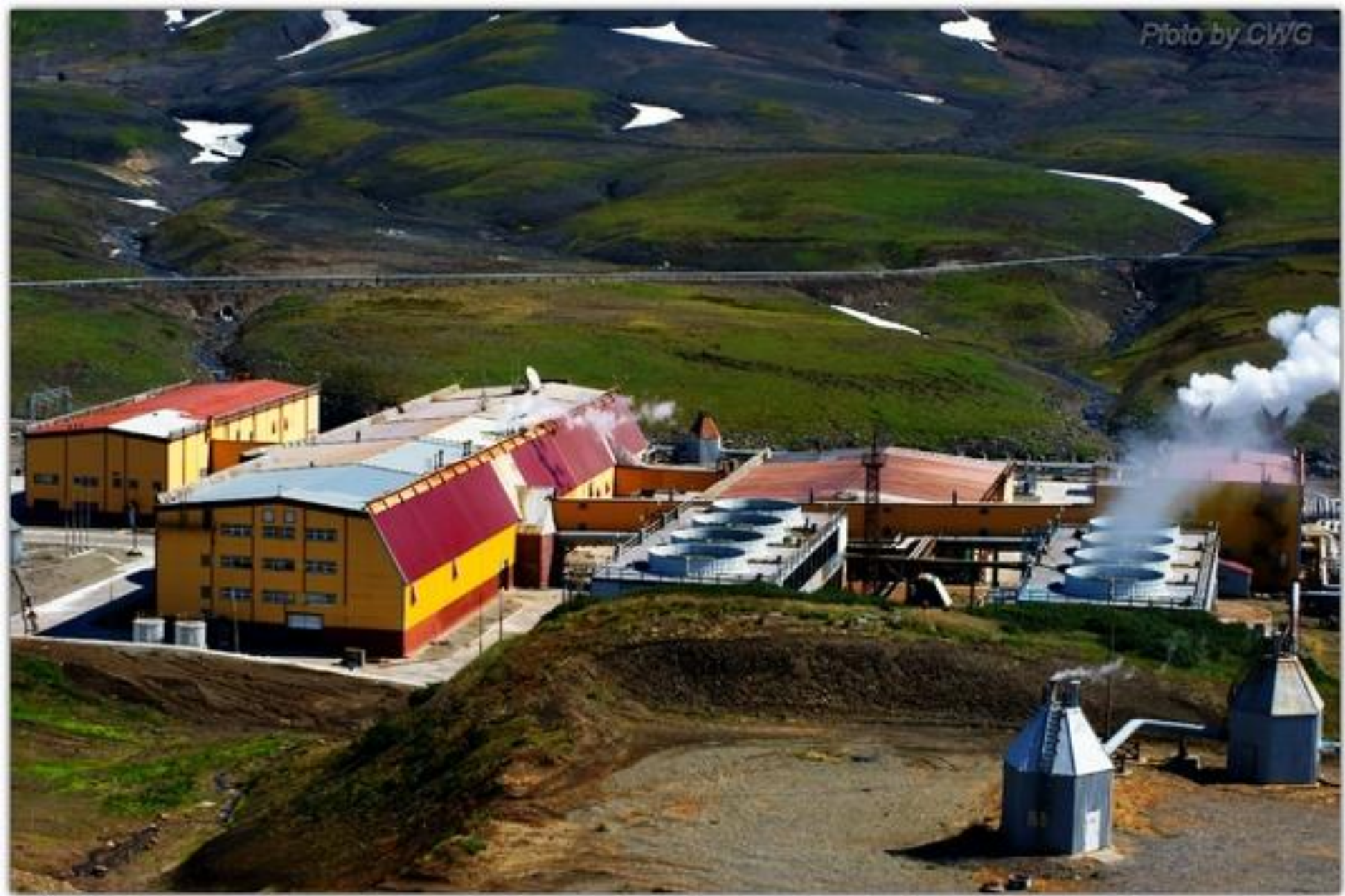
Камчатка - Мутновская Геотермальная электростанция
