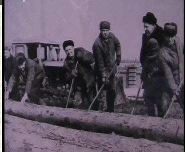
Строительство одного из объектов
