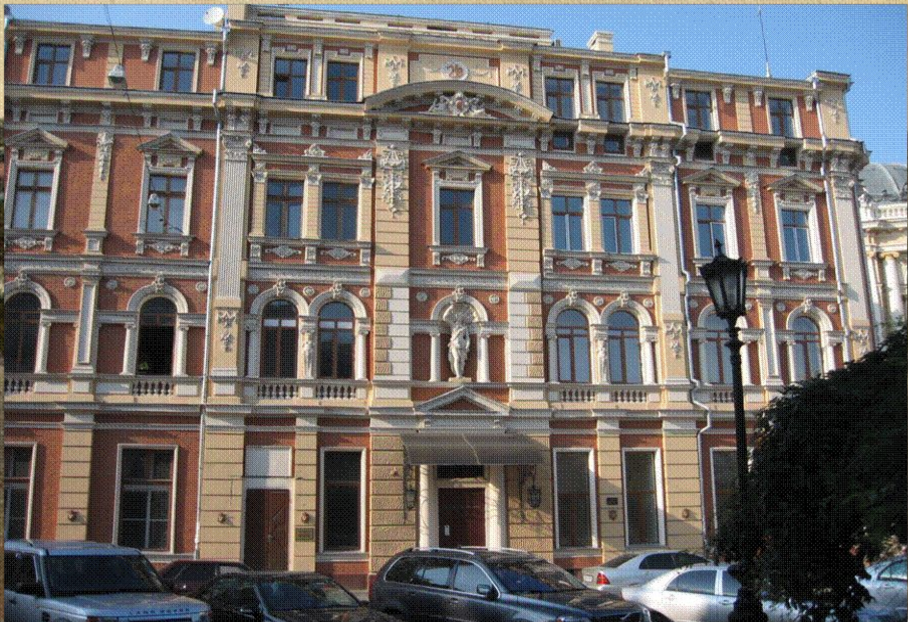
Здание Рюриковского лицея Город Николов
