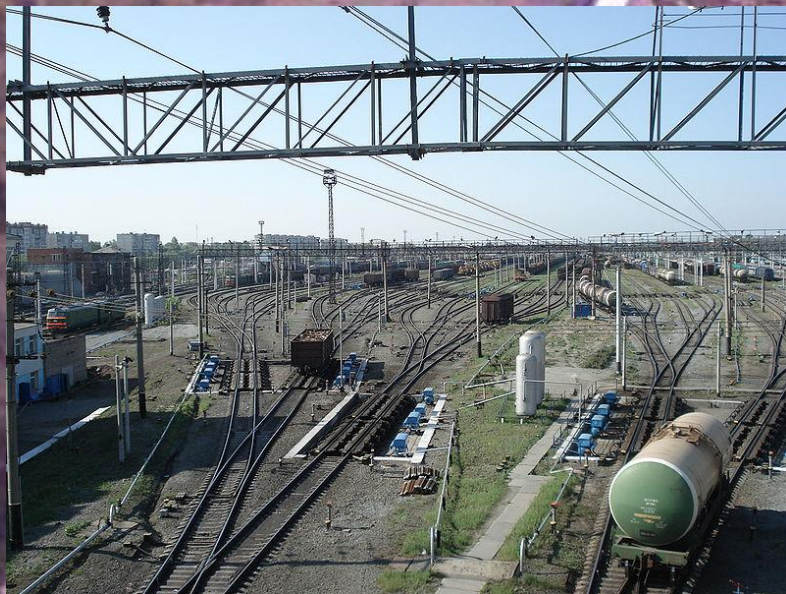
Сортировочная горка на станции Челябинск
