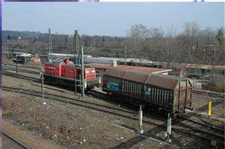
Сортировочная горка на станции Корнвестхайм (Германия)
