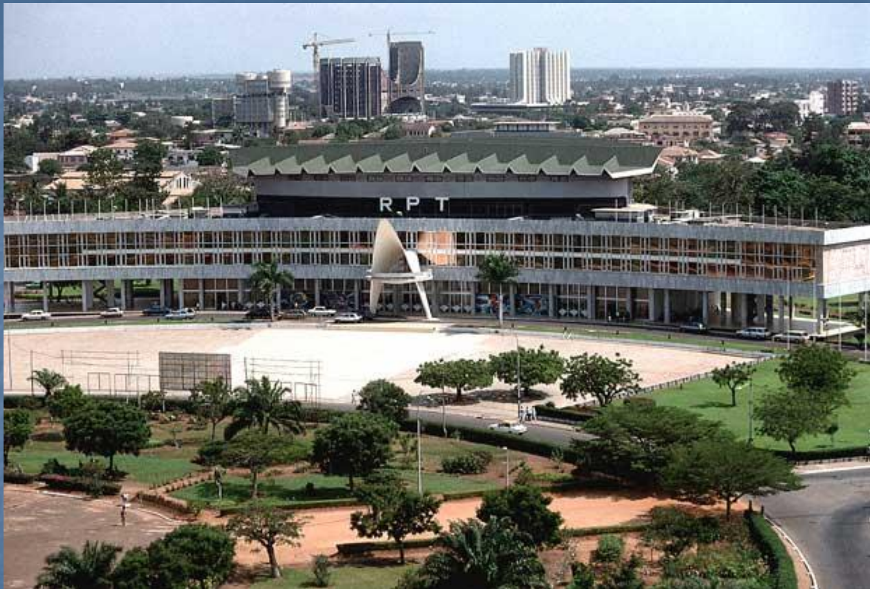
Ломе (столица Того): использование гофрированной конструкции
