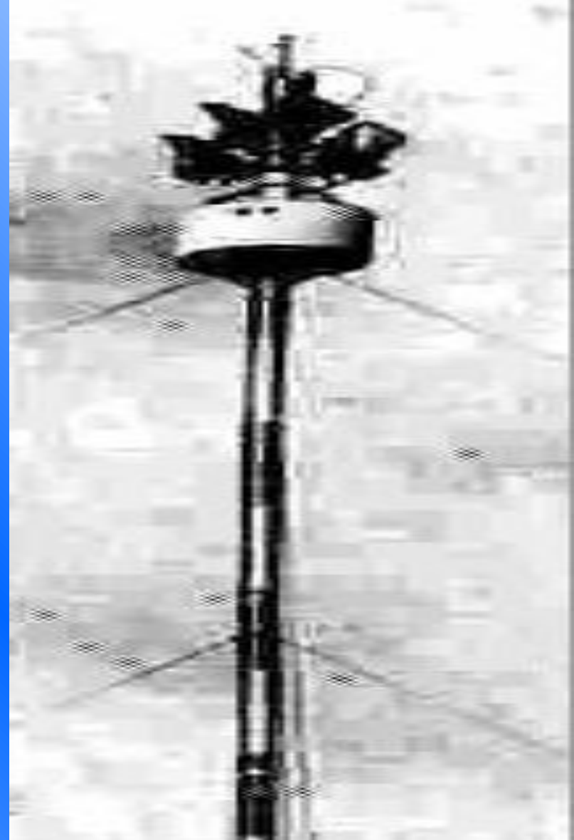
Станция линии радиорелейной связи
