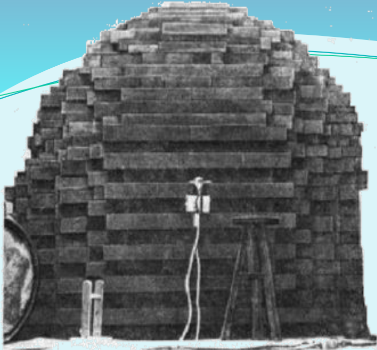
Монтаж первого атомного реактора "Ф-1" (Физический-Первый).
