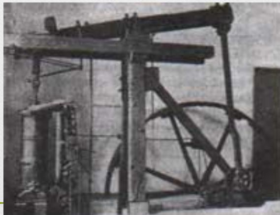
С 1776 года началось фабричное производство паровых машин. В машину 1776 года по сравнению с конструкцией 1765 года было внесено несколько принципиальных улучшений. Поршень помещался внутри цилиндра, окруженный паровым кожухом. Кожух сверху был закрыт, а цилиндр - открыт. Пар поступал в цилиндр из котла по боковой трубе. Цилиндр соединялся с конденсатором трубой, снабженной паровыпускным клапаном. Выше этого клапана был размещен еще один уравновешивающий клапан.
