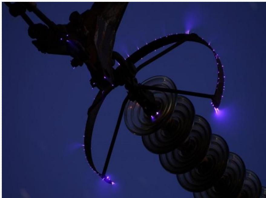
Коронный разряд на защитном кольце (экране) высоковольтной воздушной линии электропередачи напряжением 500 кВ
