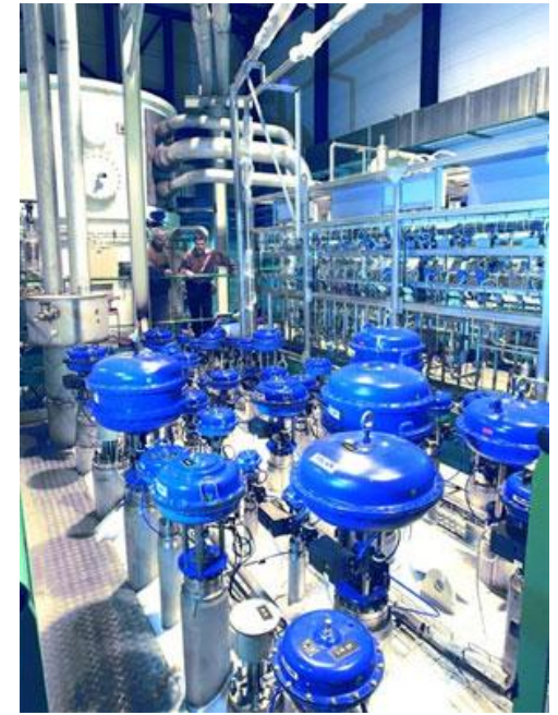
Частина системи азотно-гелієвого кріорефрижератора Великого адронного колайдера
