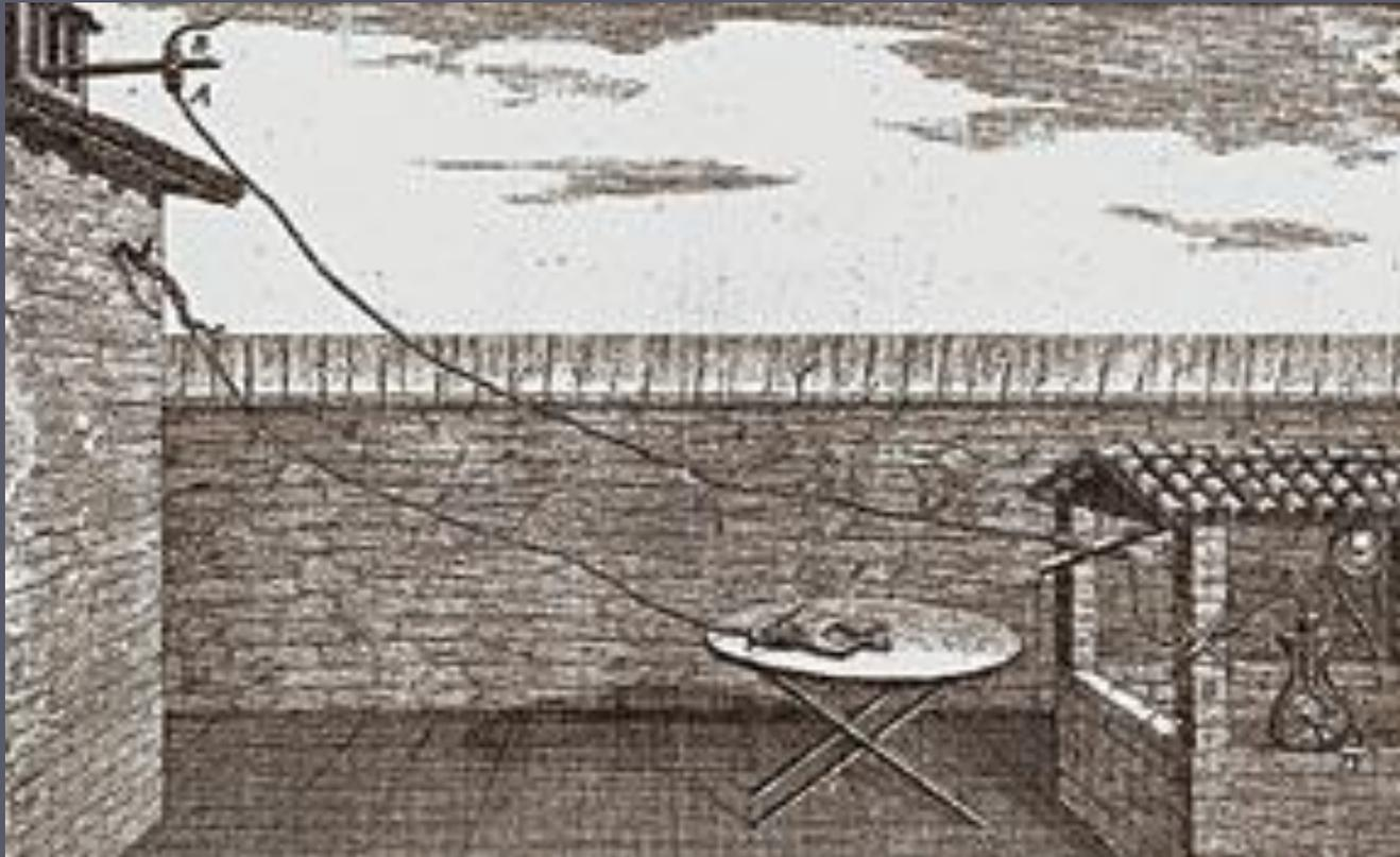
Схема опыта по изучению атмосферного электричества. Детектором служит лягушачья лапка, нерв которой соединен с громоотводом, а мышца соединена через проводник с водой в колодце. Рисунок из трактата Гальвани.
