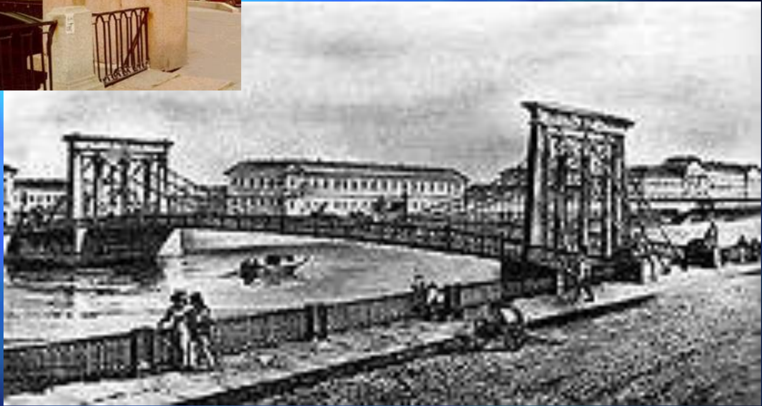
Цепной Египетского моста в Санкт-Петербурге
