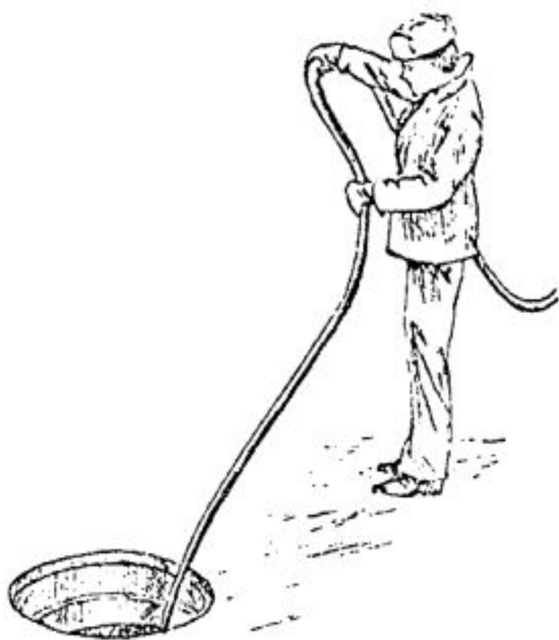
Прокручивание трубы при прокладке по каналу кабельной канализации
