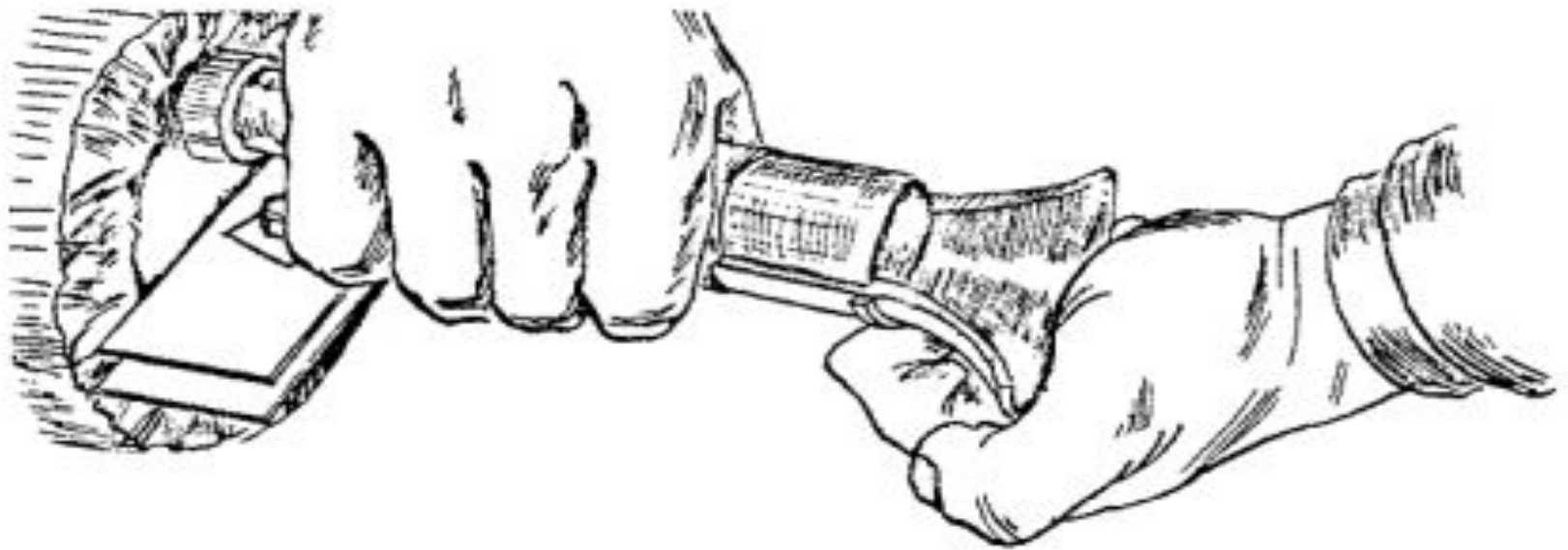
Установка направляющей воронки на полиэтиленовую трубу
