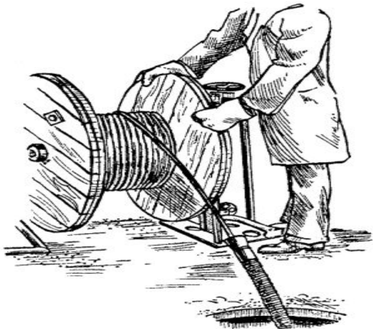
Размотка кабеля с барабана во время прокладки
