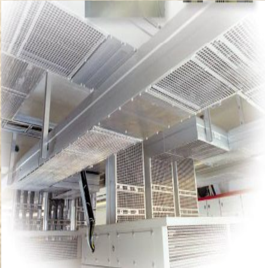
Пример электрической сети, выполненной магистральным шинопроводом MDY
