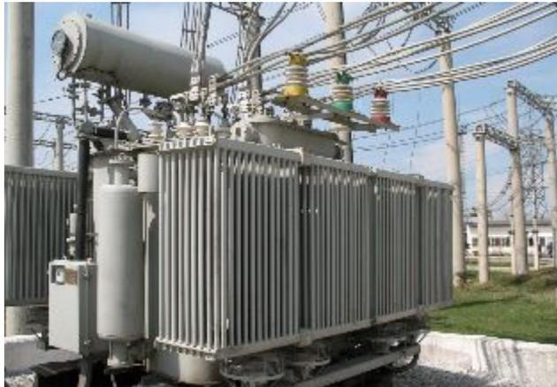
Трансформатор – статический электромагнитный аппарат, предназначенный для преобразования системы переменного тока одних параметров в систему переменного тока с другими параметрами, трансформатор состоит из магнитопровода и двух расположенных на нем обмоток.
